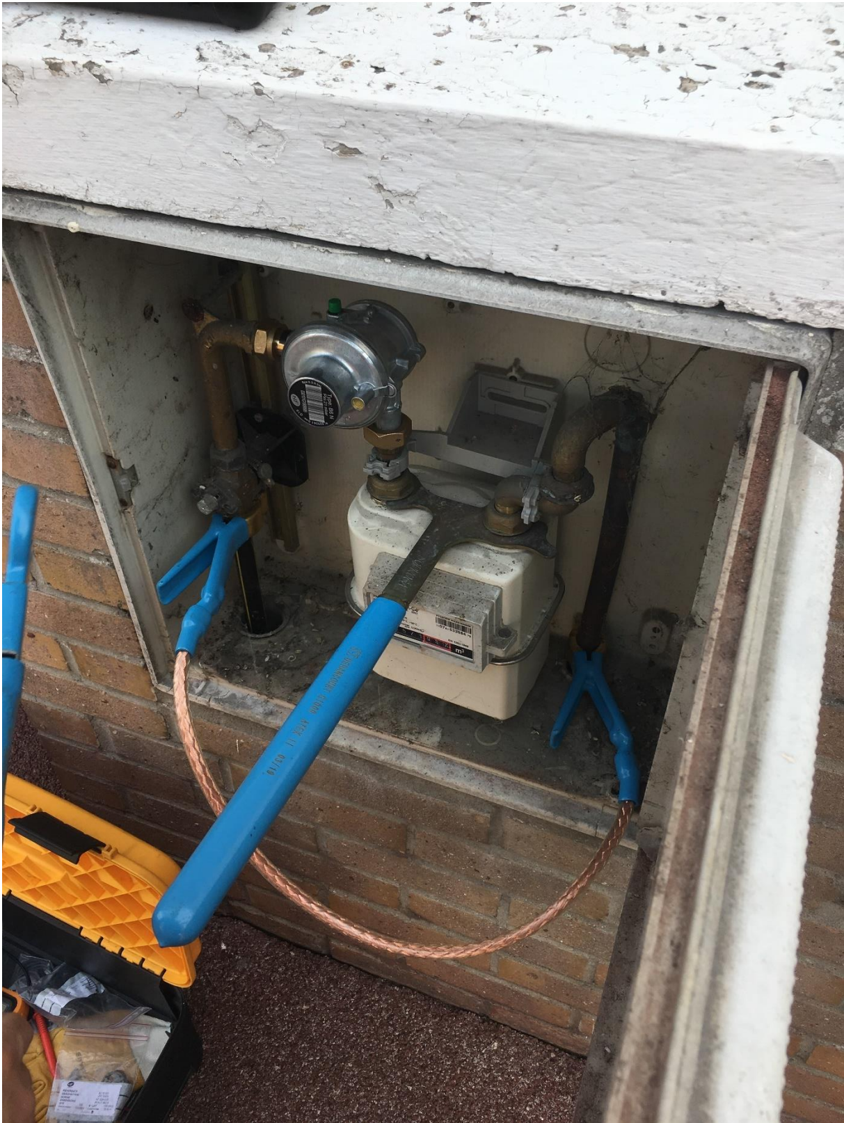
Légende : Changement de détendeur sur le poste gaz d'un particulier
